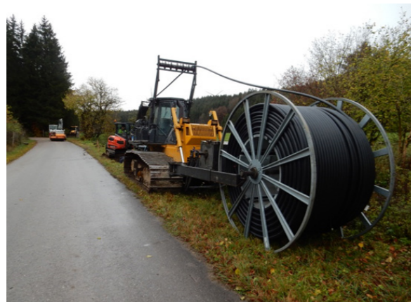
Abb. 1: Kabelverlegung zwischen Windenergieanlagen und Heizzentrale (Ingenieurbüro Sing)
