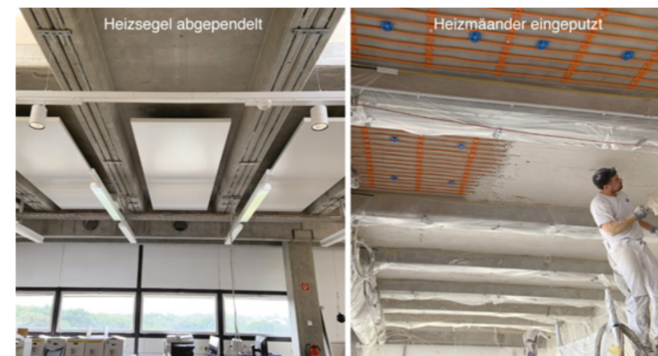
Abb. 2: Integration der Niedertemperatur-Deckenheizsysteme in den Gebäudebestand
