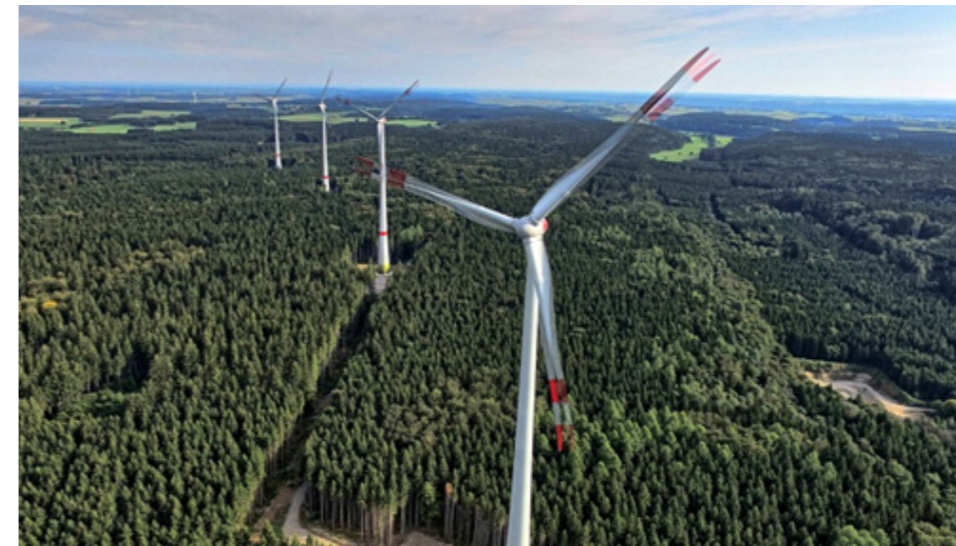
Abb. 2: Windenergieanlagen in der Gemeinde Fuchstal (Gemeinde Fuchstal)
