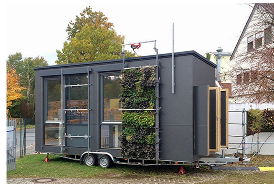
Abb. 1: Rednitzhembach, Technikum: EnOB: GreenFaBS-Versuchstand. Referenzbüro mit DFL (links) und Aufbau mit Fassadenbegrünung und DFL (rechts) (Quelle: Roland Krippner)
