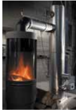
Abbildung 2: Kaminintegrierter Carola-Abscheider.
