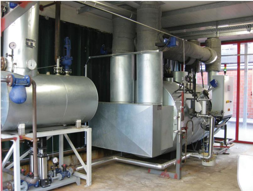
Abbildung 10: Abhitzedampferzeuger einer dezentralen Brennerie
