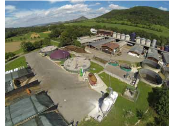
Abbildung 2: Forschungsbiogasanlage Unterer Lindenhof mit installiertem MeWa Bio-QZ 900 am Fermenter 1
