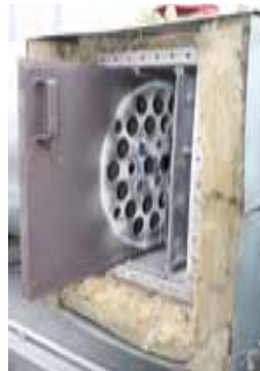
Abbildung 6: Fotografie der Vorrichtung zur Installation der Einschubmatrize in den Abgastrakt des BHKW
