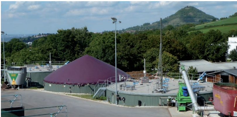
Abbildung 2: Forschungsbiogasanlage Unterer Lindenhof mit installiertem MeWa Bio-QZ 900 am Fermenter 1
