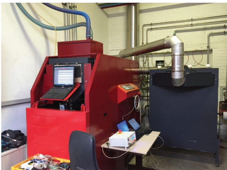
Abbildung 2: Testanlage 160 kW th Pelletkessel mit Single EFC
