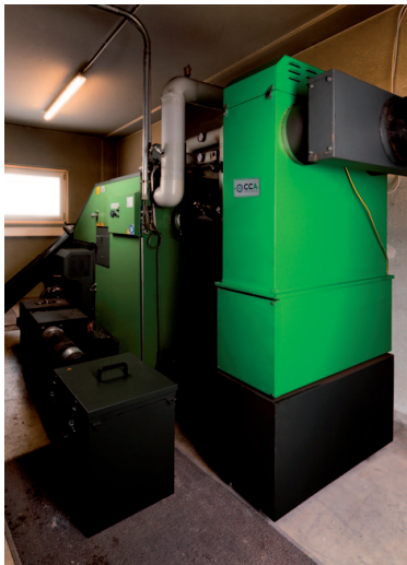
Abbildung 2: Feldversuch des Carola®-Abscheiders an einem 100 kW-Hackgutkessel in Massing
