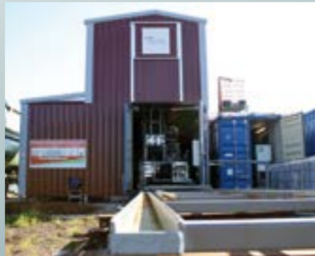
Über die Erfahrungen beim Errichten einer HTC-Demonstrationsanlage in Halle-Lochau lesen Sie ab Seite 13
