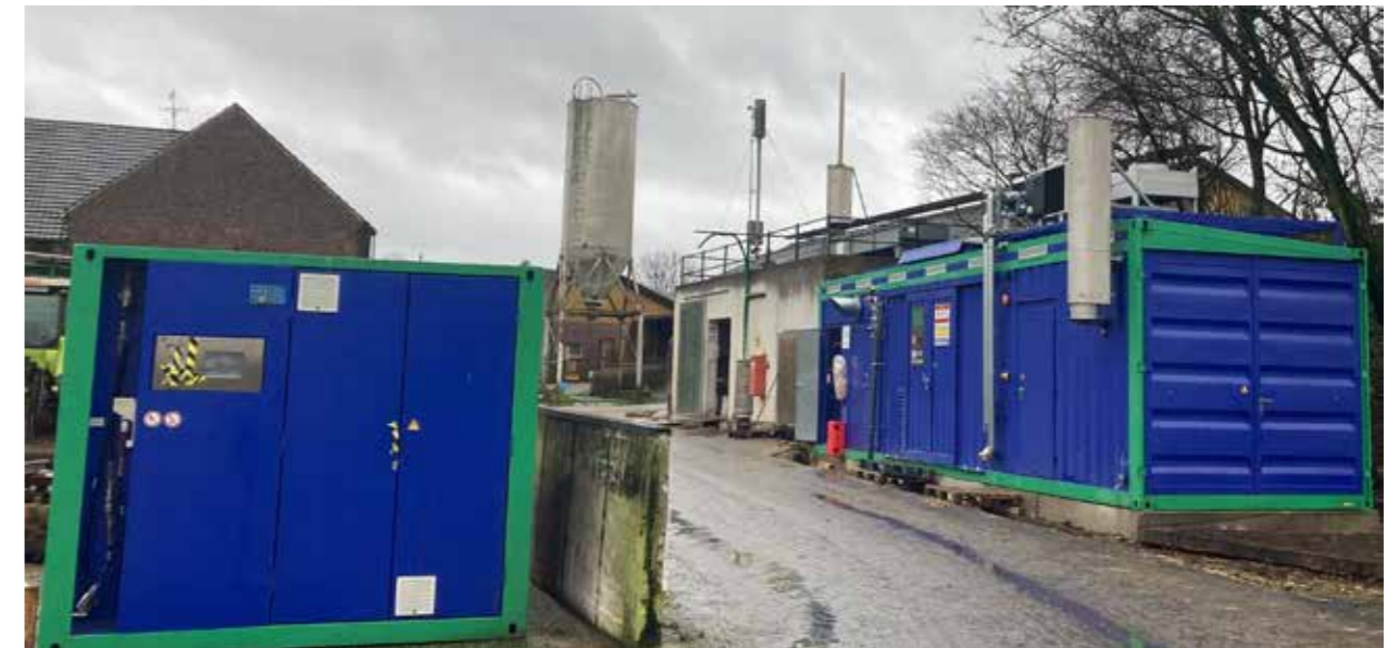
Abbildung 1: Die Anlage am Projektstandort
