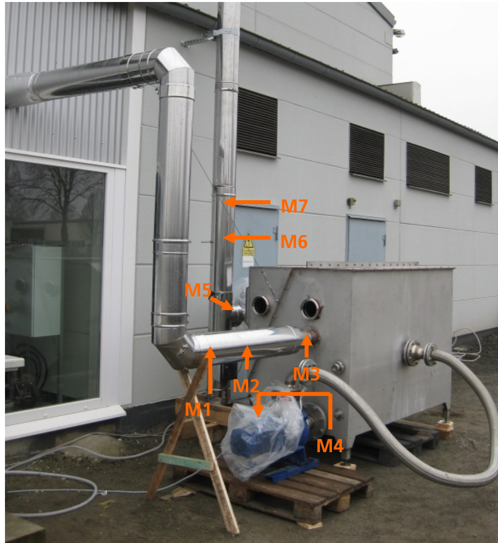
Abbildung 63: Versuchsaufbau Wäscher - Messstellen
