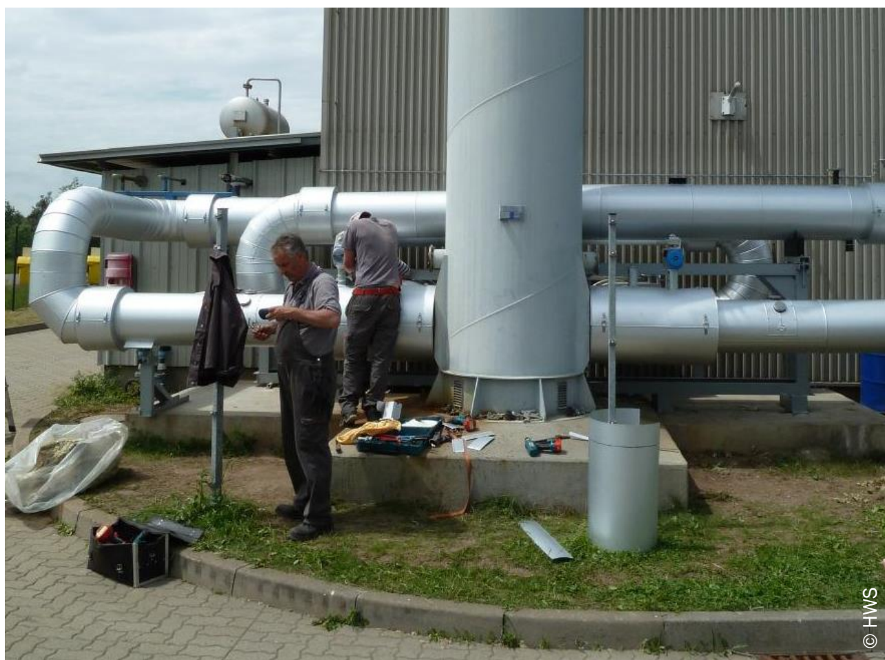
Abbildung II-7: Montage Abgaswärmetauscher.
