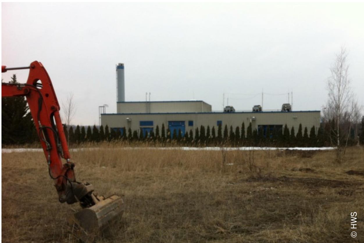
Abbildung II-6: Deponiegas-BHKW Nord auf dem Deponiegelände der Abfallwirtschaft GmbH Halle-Lochau.
