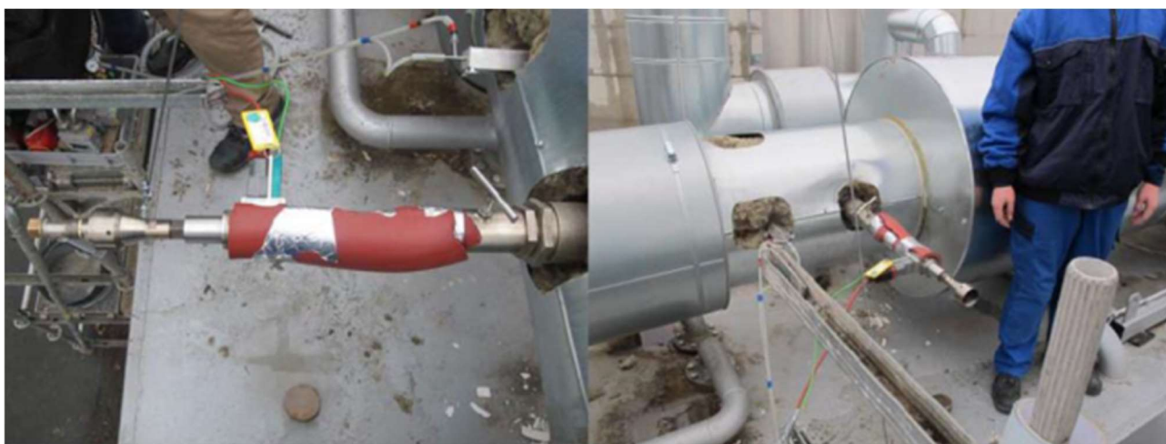
Abbildung 56 Fotografien der installierten Staubprobenahmesonde (links: Draufsicht, rechts: Seitenansicht)
