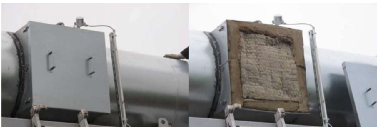
Abbildung 57 Fotografien der modifizierten Katalysatorisolierung (links: mit Deckel, rechts: ohne Deckel)
