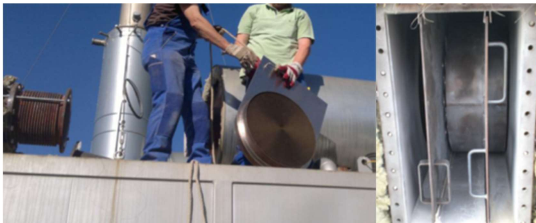
Abbildung 59 links: Fotografie des Methankatalysators (Demonstrator) vor dem Einbau; rechts: Fotografie des im Wechselgehäuse eingebauten Methankatalysators
