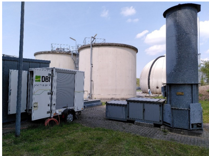
Abbildung 45: Einbindung auf der Kläranlage Radeberg (Quelle DBI)
