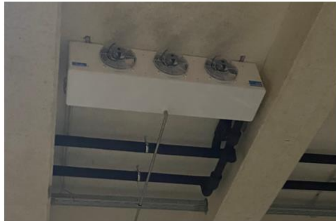
Abbildung 9: Gekühltes Flaschenlager (links), luftbeaufschlagter Verdampfer (rechts)
