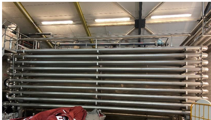
Abbildung 4: Gegenstromwärmeübertrager für Wärmerückgewinnung aus Traubenmost
