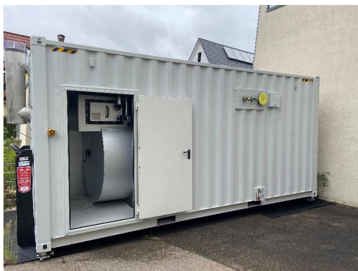
Abbildung 5: Eco 1500 Dampfkessel für die Maischeerhitzung
