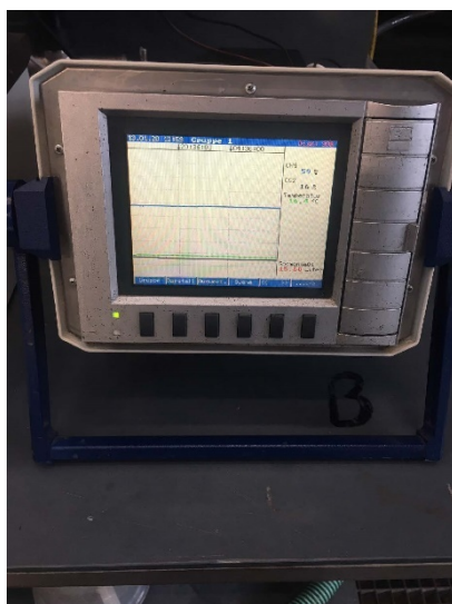
Abbildung 3-17 Datenlogger der Firma Endress + Hauser - Halb technische Untersuchung
