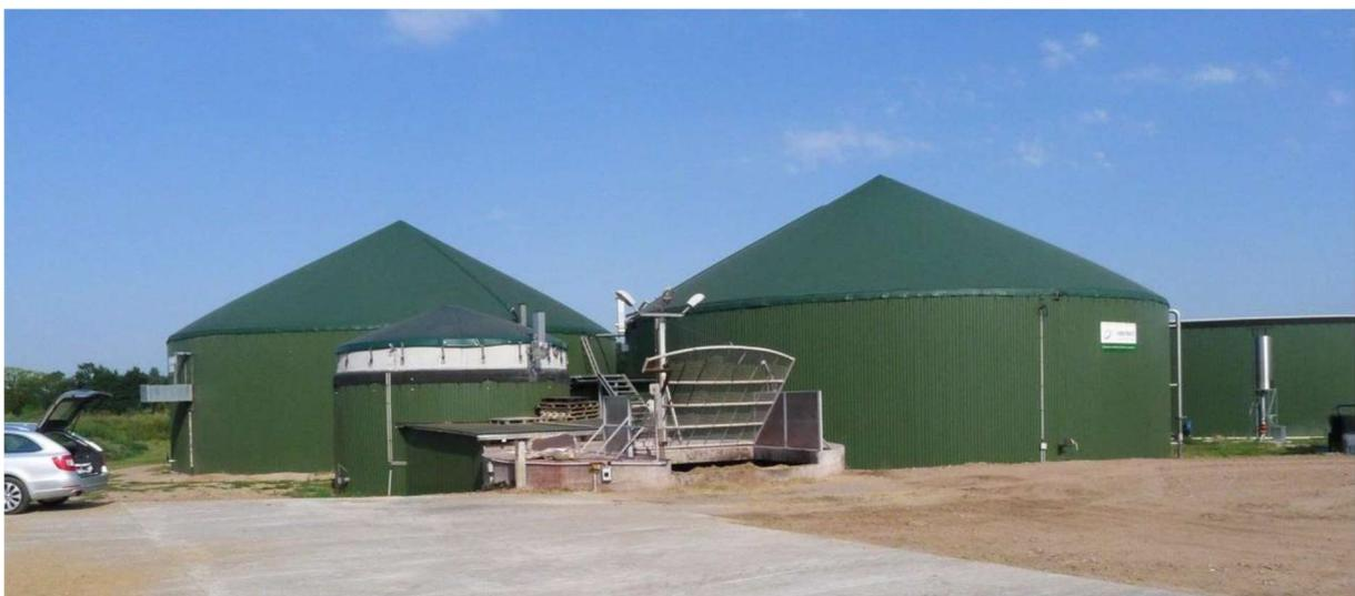
Abbildung 48: Gesamtansicht der BGA Bergzow. Von links: Fermenter, Güllepufferbehälter (ehemalige Hydrolyse- und Versäuerungsstufe), Anmaischer, Nachgärer und Gärrestlager (Abb.: Cordes+Winterberg 2015).
