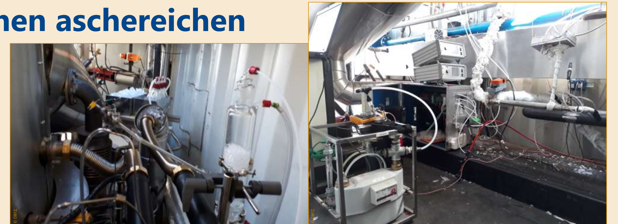
Abb. 3: Messtechnikaufbau einer Versuchsreihe zur Anlagenoptimierung
