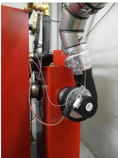
Bild 2: 20180525 Bild 2 Abscheidebox mit Saugzuggebläse.jpeg BU: Abscheidebox mit Saugzuggebläse (Quelle: IZES)
