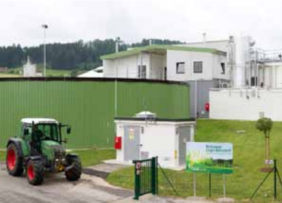
Biogas plant Engerwitzdorf, photo: ARGE Kompost & Biogas Österreich
