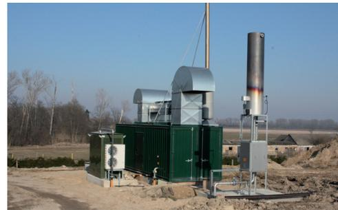
BHKW-Container mit Notfackel zur Produktion von Strom und Wärme. Beheizt werden Wohnhaus, Werkstatt sowie der Melkstand des Kaim Agrar-Service in Berge.
