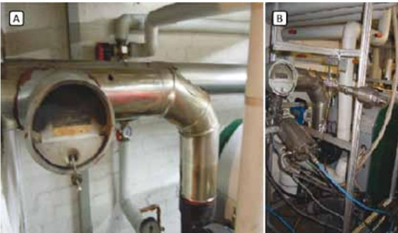
Abbildung 16: Beispiel für Rauchgasrohr vor (Bild A) und nach Installation der Messtechnik (Bild B)
